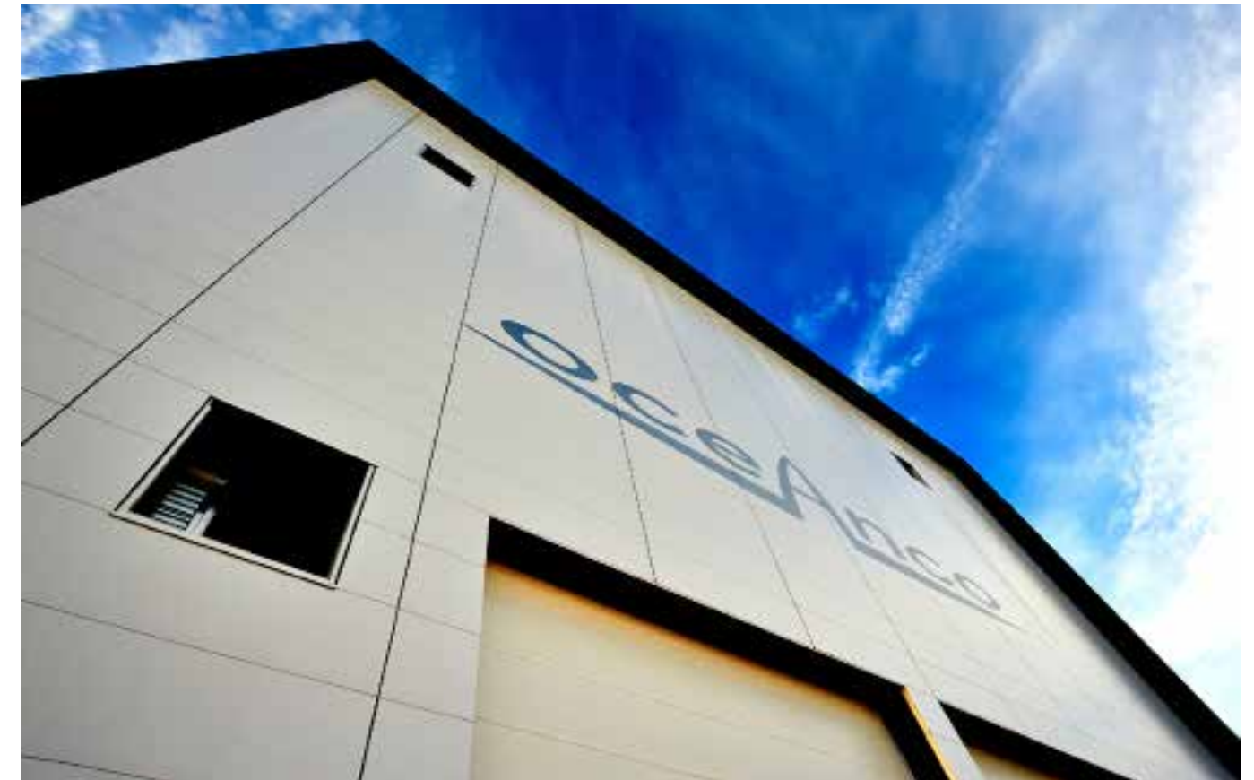
Behalve het droogdok en de spuitloods worden in het gebouw eraast 2.800 m 2 kantoren en 13.000 m 2 werkplaatsen, een kantine en technische ruimten gerealiseerd
