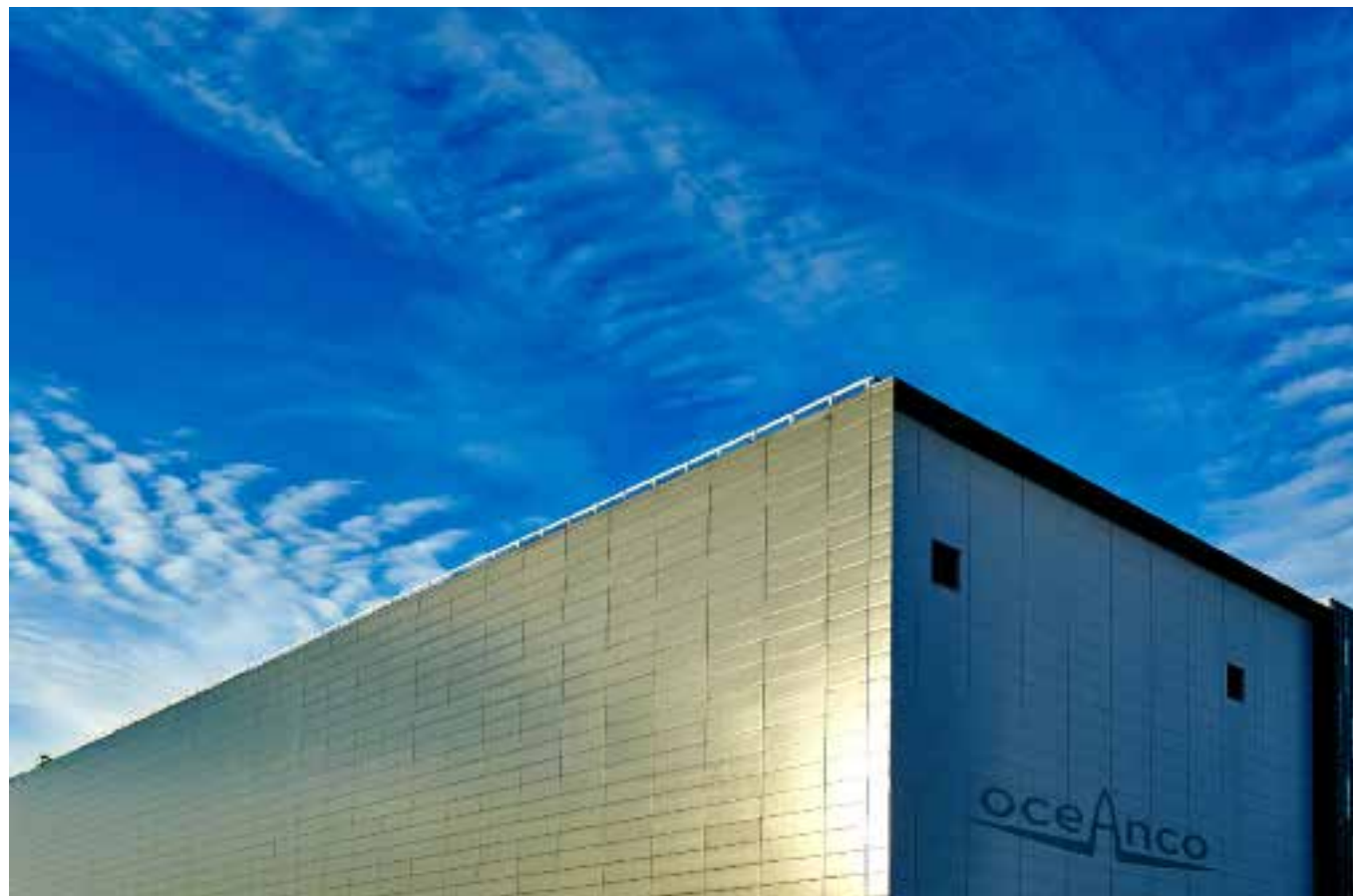
'De jachtbouwhal heeft een oppervlakte van 5.500 m 2 , is 33 meter hoog en wordt voorzien van een droogdok met een diepte van 10 meter.'
